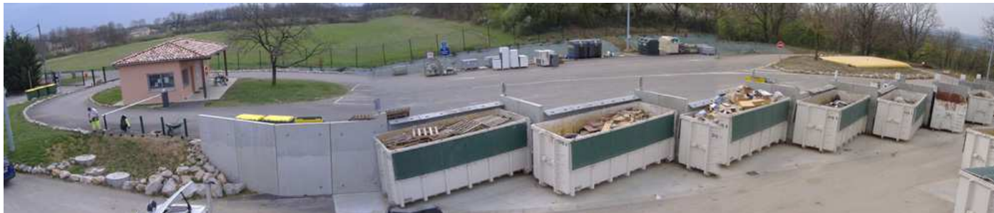
Vue de la déchèterie de Dieupentale
